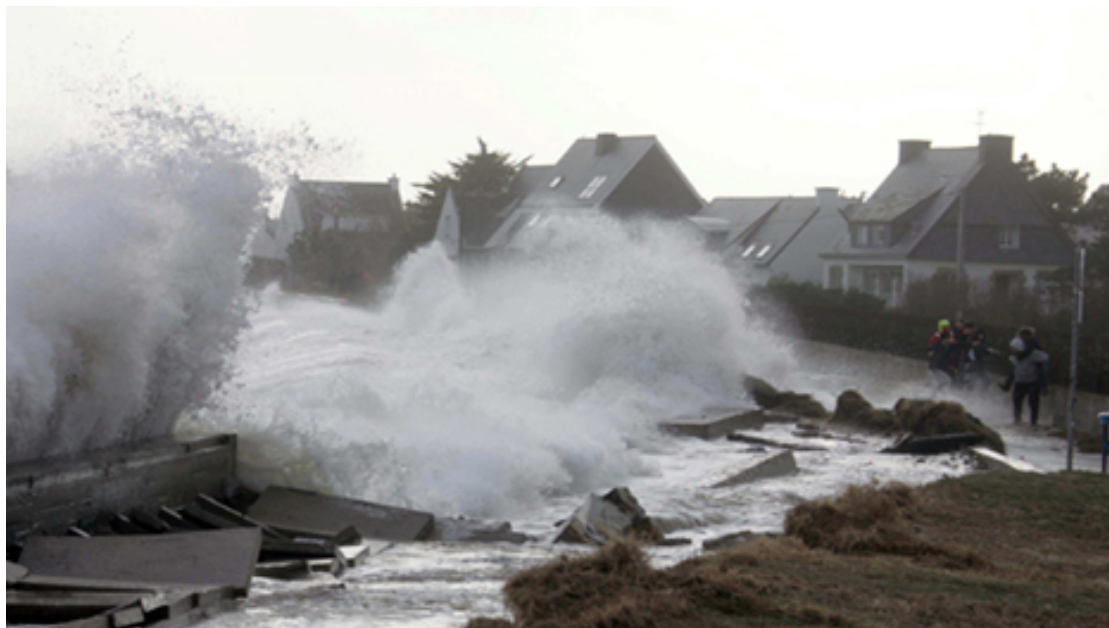
Phénomène de franchissement d'ouvrage à Gâvres dans le Morbihan lors de la tempête Johanna. © DDTM 56
