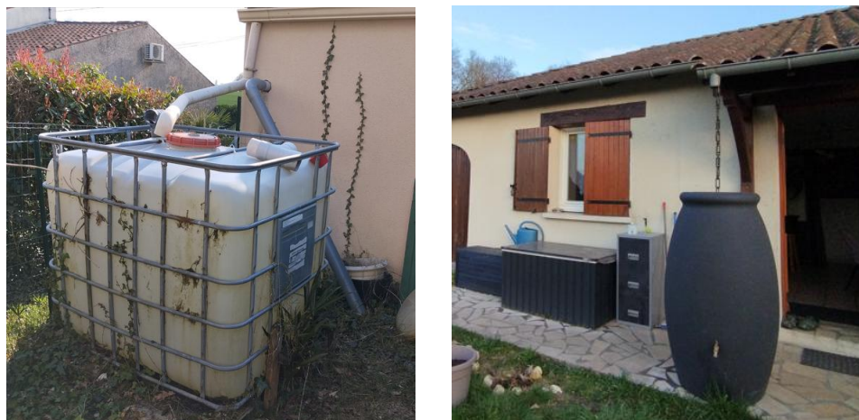
Fig. 90: Exemples rencontrés de dispositifs de récupération des eaux pluviales sans évacuation du trop-plein (photographies prises en mars 2025-périphérie de Niort et Bordeaux)
