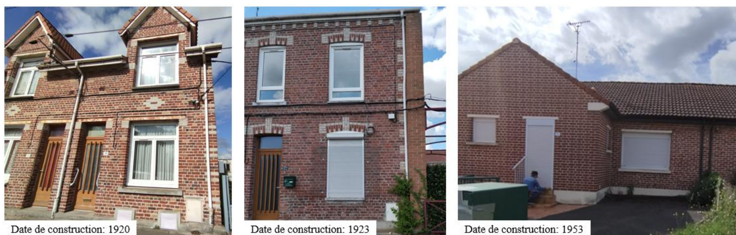
Fig. 76: Maisons diagnostiquées et leur date de construction présumée (démarche avec le bailleur) (photographies prises en août 2024 – Courrières et Aniche)
