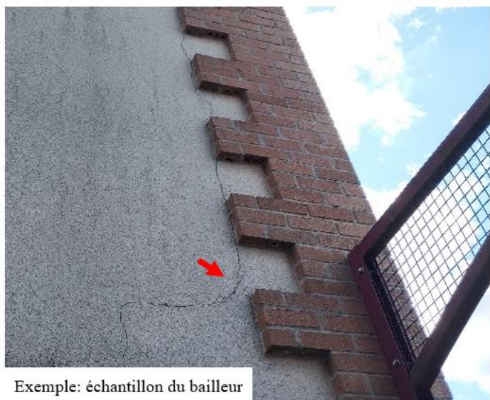
Fig. 79: Fissures observées sur les maisons diagnostiquées (photographies prises en août 2024 et mai 2025 – Carvin et périphérie Bordeaux)
