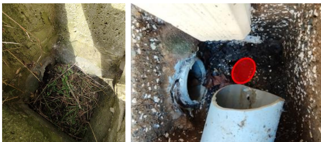
Fig. 89: Exemples rencontrés sur le terrain de regards potentiellement sinistrants (photographies prises en avril 2025 – périphérie de Niort)
