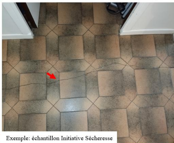
Fig. 79: Fissures observées sur les maisons diagnostiquées (photographies prises en août 2024 et mai 2025 – Carvin et périphérie Bordeaux)
