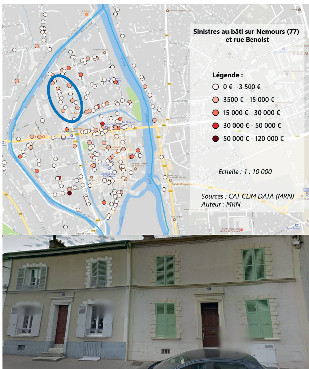
Maisons voisines sinistrées sur la rue Benoist (Nemours, 77) Source : Google Street View
