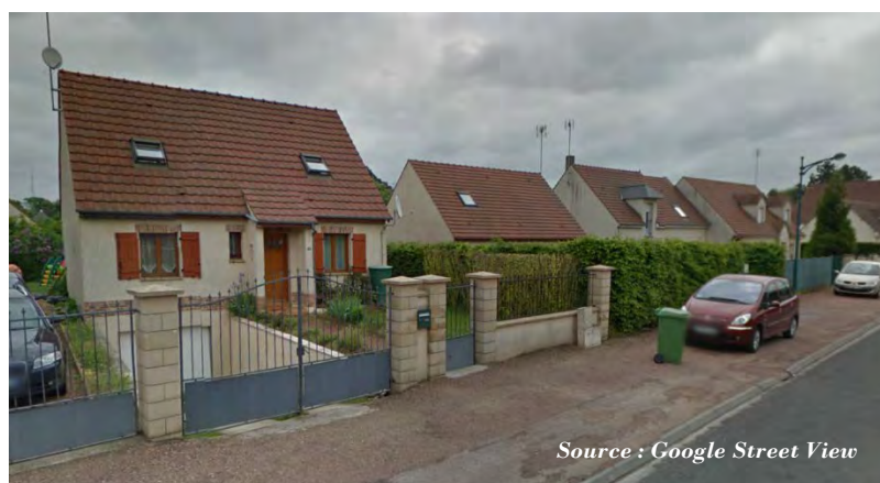
Figure 65. Profil type des habitations sinistrées en 2007 à Guiscard
