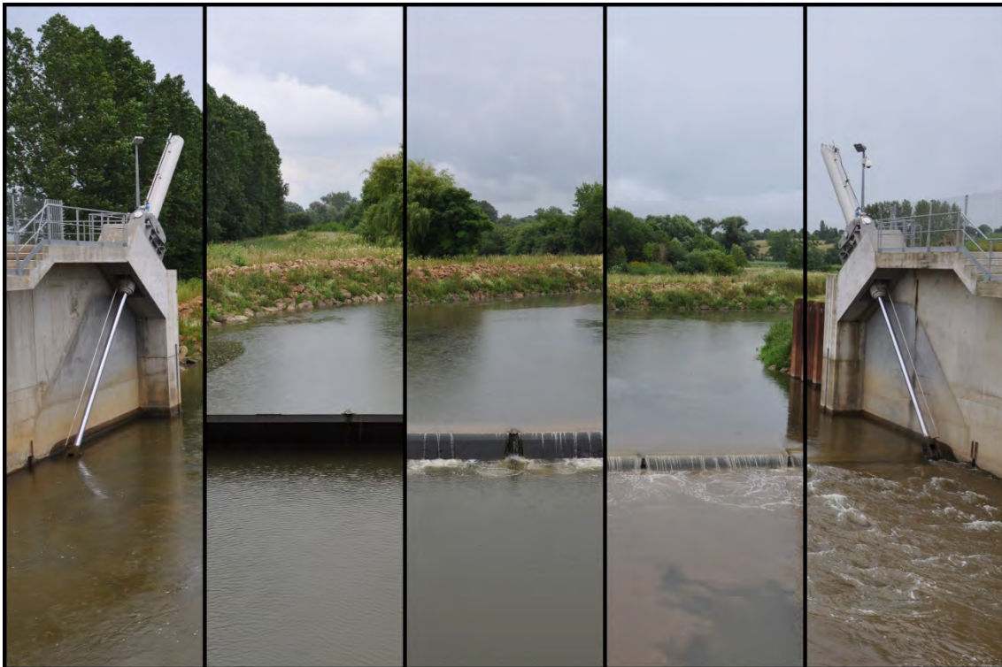
Figure 69. Fonctionnement du clapet mobile (Proisy)
