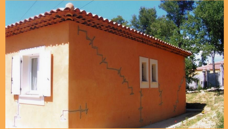
Effets du retrait-gonflement des argiles sur un habitat pavillonnaire, (©AQC)
